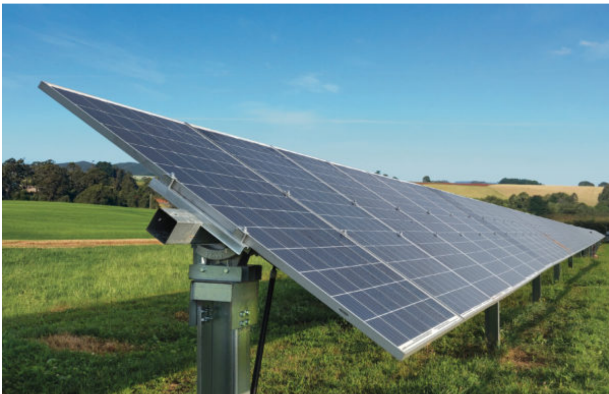
Figure 2 Immagine esplicativa dell'allestimento dei pannelli sulla struttura tracker
