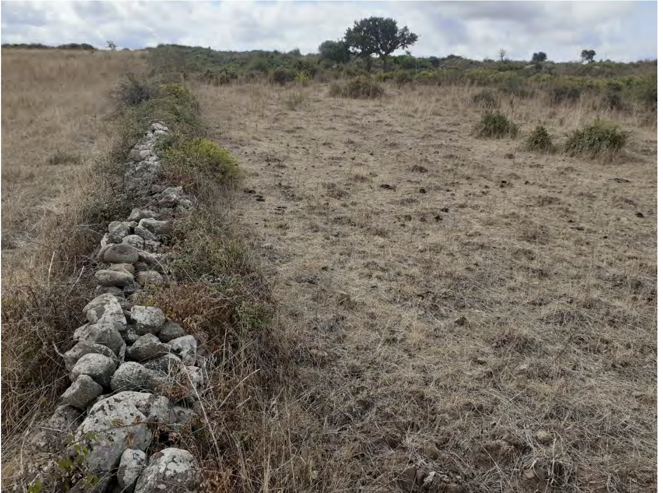
Fotografia P4 vista all'interno del sito del muro in pietra perimetrale esistente
