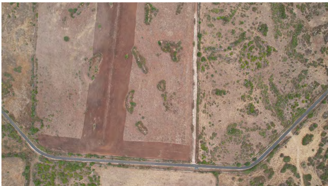
Fotografia 1 : Area dove è prevista la realizzazione di n.2 cabine di consegna
