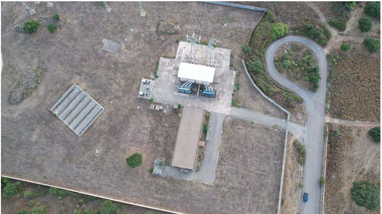
Fotografia 14 : Vista aerea della cabina CP di Suni dove è previsto l'allaccio
