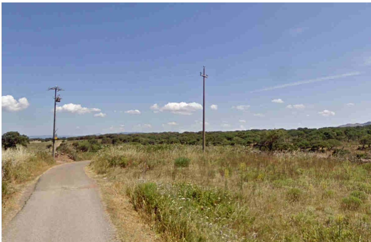
Fotografia 9 : Area dove è previsto il passaggio delle linee aeree MT al di sopra della linea MT esistente
