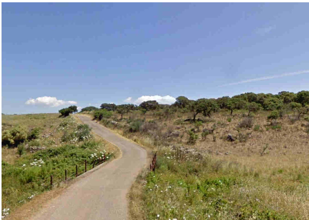
Fotografia 6 : Vista del tratto dove è previsto l'attraversamento delle linee aeree MT sul Riu Ferralzos
