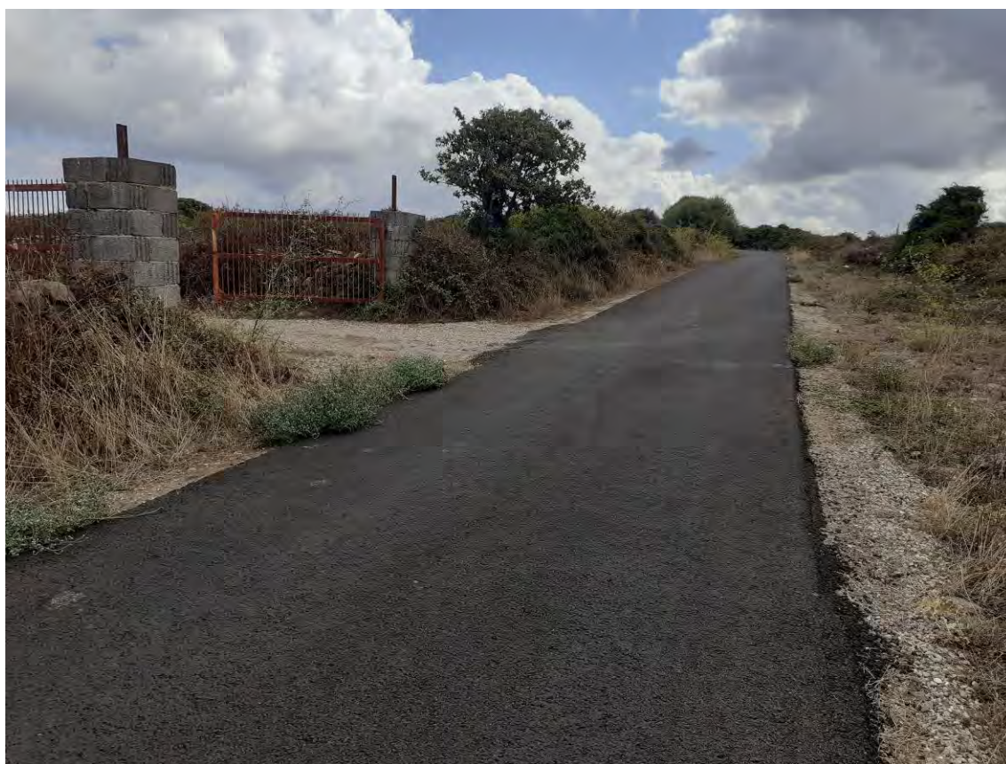
Fotografia 2 : Area dove è prevista la realizzazione di n.2 cabine di consegna
