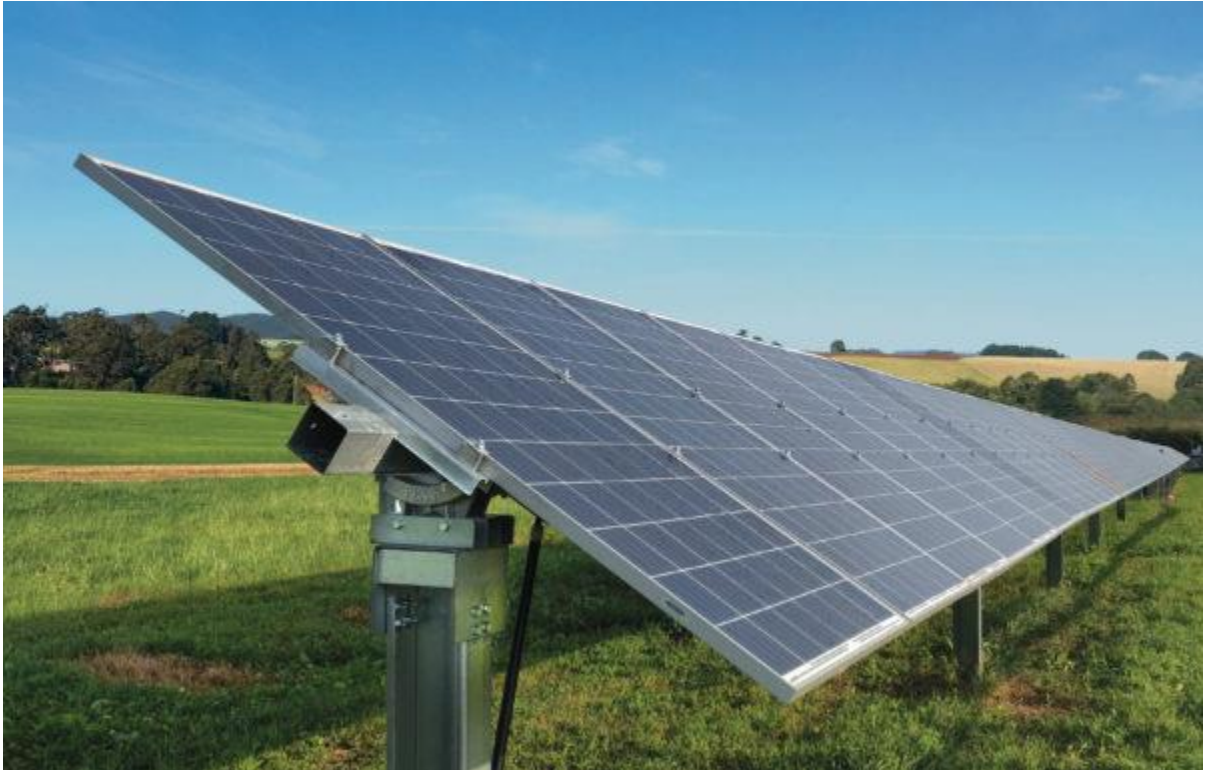
Figure 3 Immagine esplicativa dell'allestimento dei pannelli sulla struttura tracker
