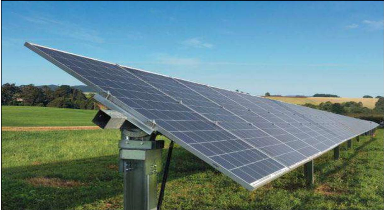
La struttura è formata da un telaio metallico sul quale viene assemblata una fila di pannelli in orientamento "landscape". La fila di pannello è incorniciata in posizione baricentrica lungo l'asse mediano su una struttura portante costituita da una trave metallica, sorretta da una serie di pilastri in profilato IPE che vengono infissi nel terreno.
