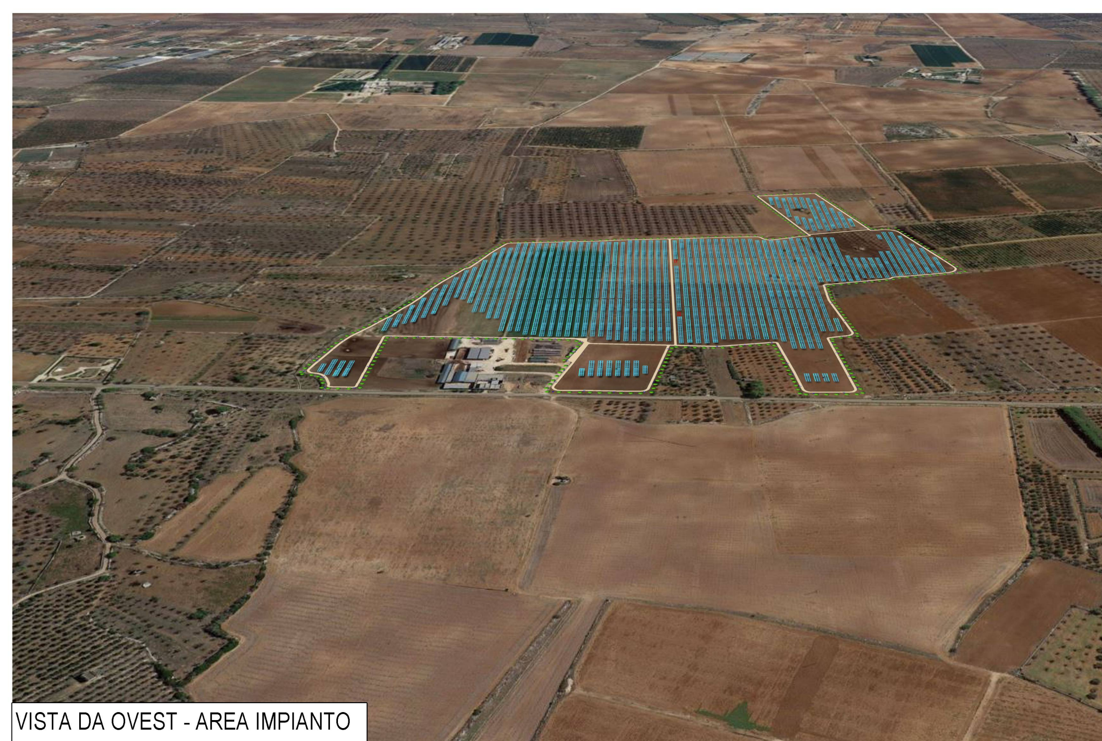
VISTA DA OVEST - AREA IMPIANTO
