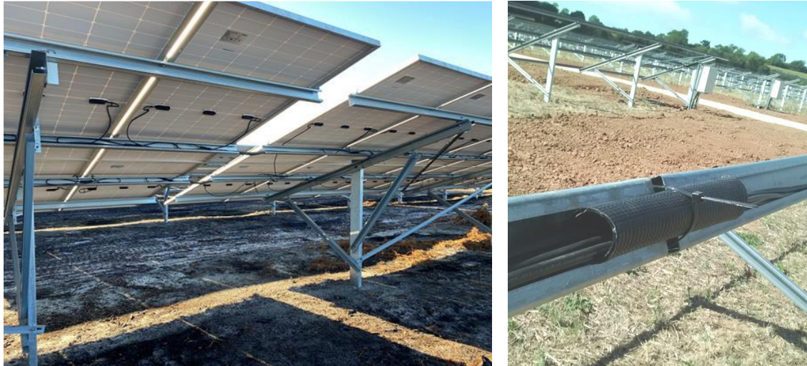
Figura 3: cablaggio stringhe
