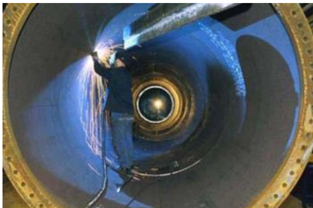
Figura 10 - interno di una torre
