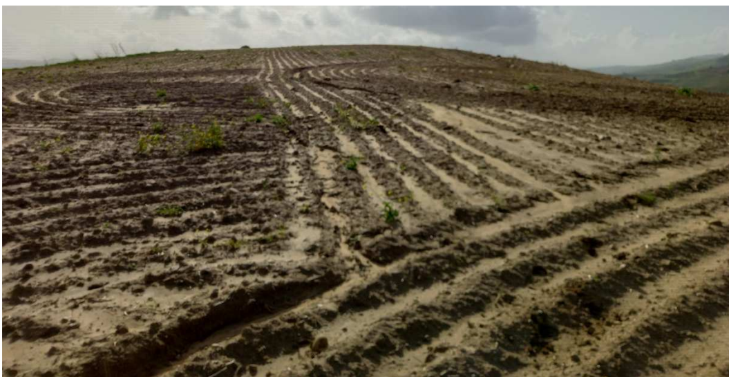
Foto 34-35-36. Superfici Aerogeneratore CAN_12
