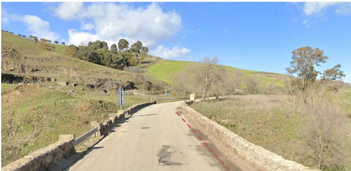
Figura 69: Immagine acquisita da strada provinciale 28ii in corrispondenza dell'attraversamento dell'elemento idrografico classificato come asta secondaria del Vallone Novevolte. Si tratta di strada asfaltata e pertanto il cavidotto verrà previsto interrato. L'intervento è ascrivibile ad un tempo limitato e pertanto verranno immediatamente ripristinate le condizioni ante operam .
