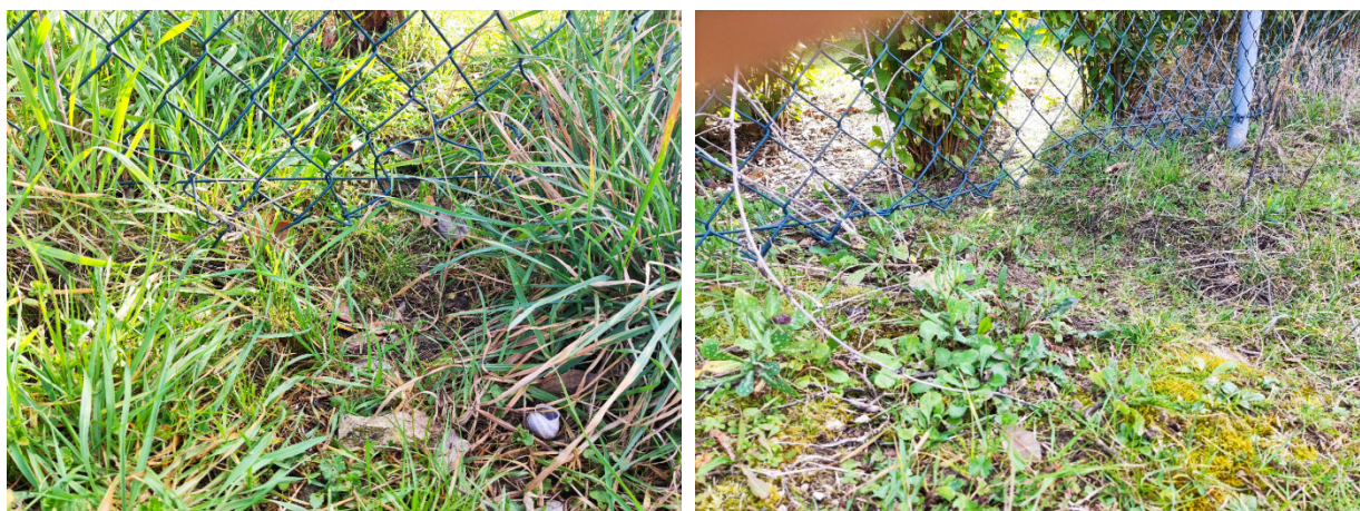
Figura 8-9. Esempi di scavo per l'attraversamento della rete metallica
