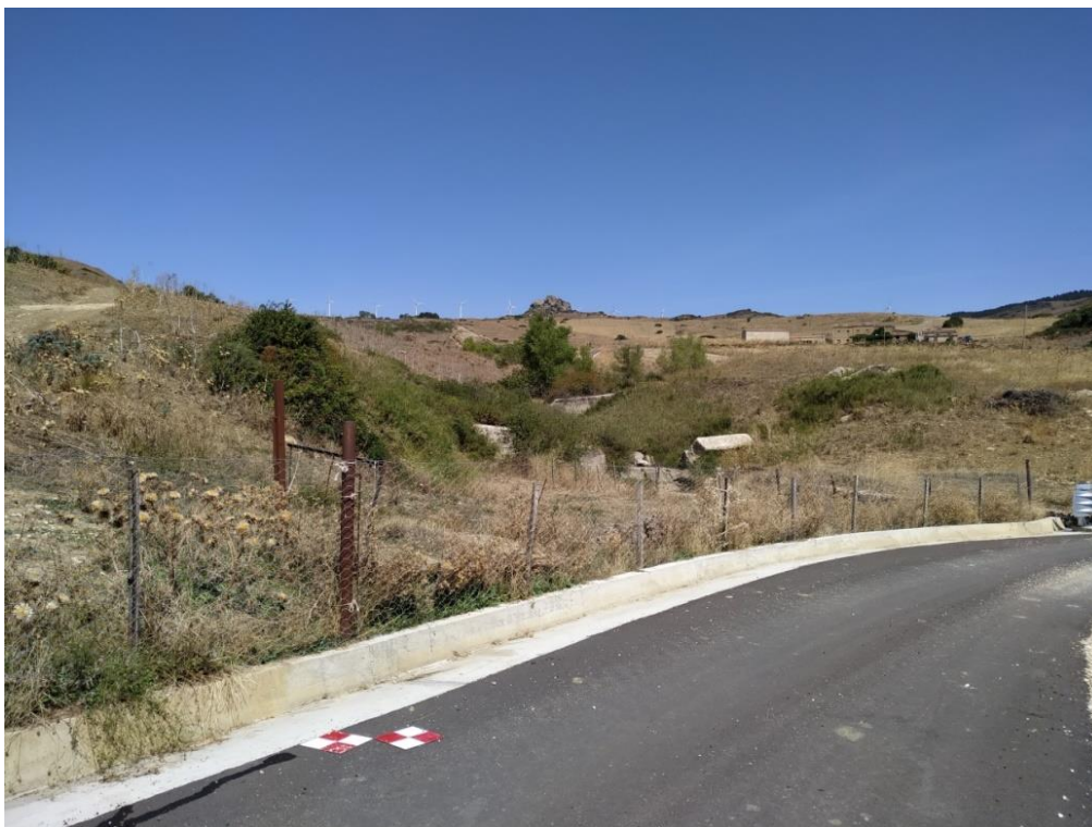
Figura 41- Foto panoramica A6
