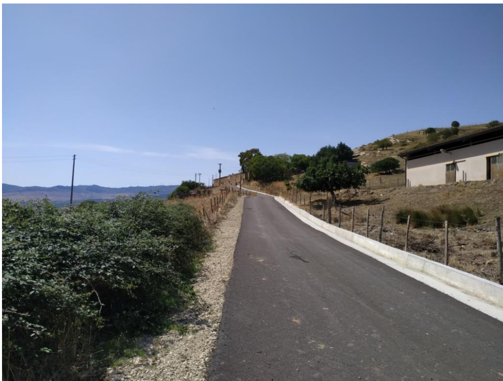
Figura 36- Foto panoramica A1
