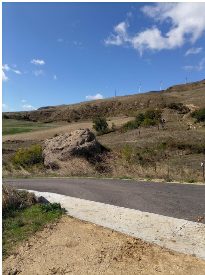
Figura 56- Foto panoramica C3
