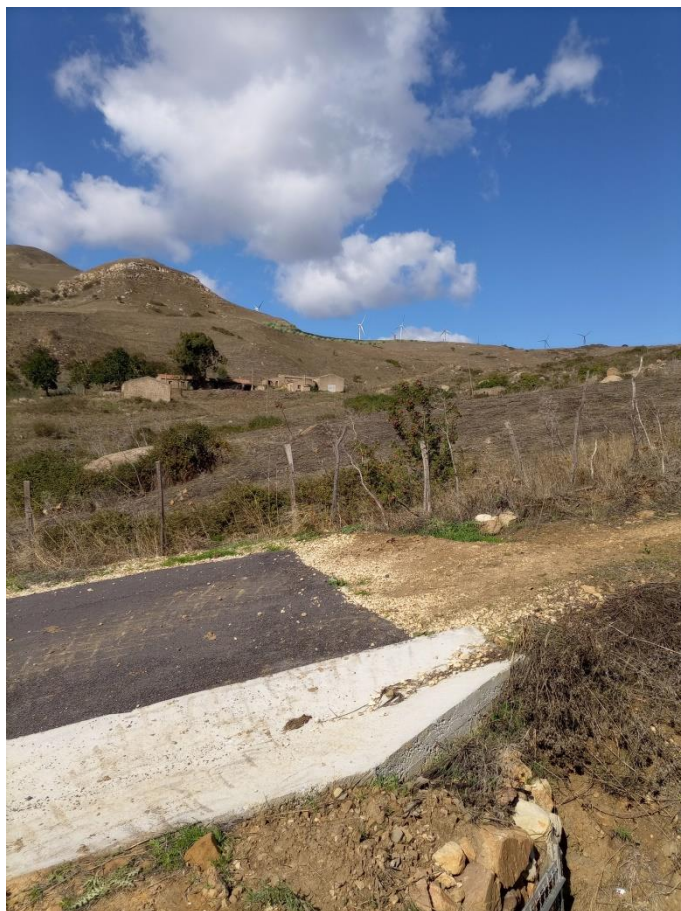
Figura 70- Vista B (Post Operam)
