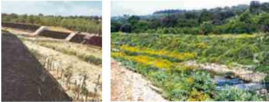
Figura 10. A sinistra - geostuoia tridimensionale in fibre di polipropilene. A destra georete tridimensionale rinforzata con una rete metallica a doppia torsione a maglie esagonali.
