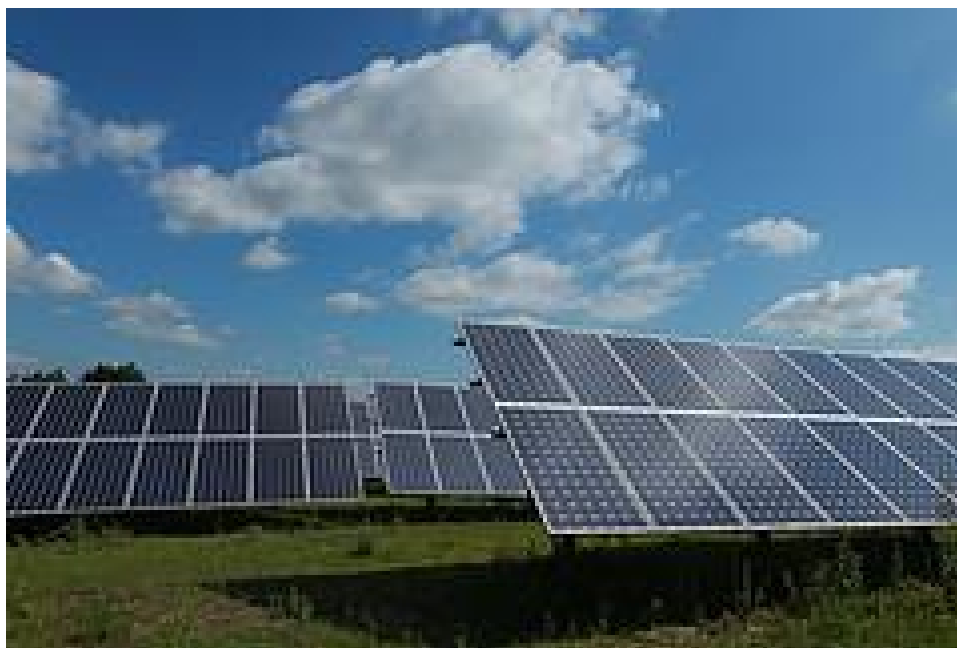
Figura 4: Esempio di impianto realizzato al suolo, fisso, con pannelli in configurazione bifilare
