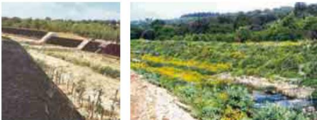
Figura 7 - Sponde di una fiumara rivestite con geostuoia tridimensionale rinforzata e rinverdita.
