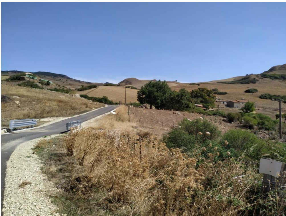
Figura 43- Foto Panoramica A8
