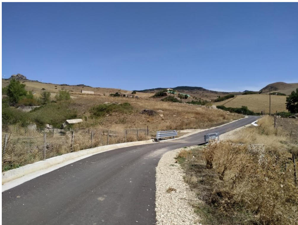
Figura 42- Foto panoramica A7
