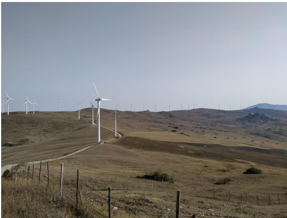
Figura 49- Foto panoramica B3
