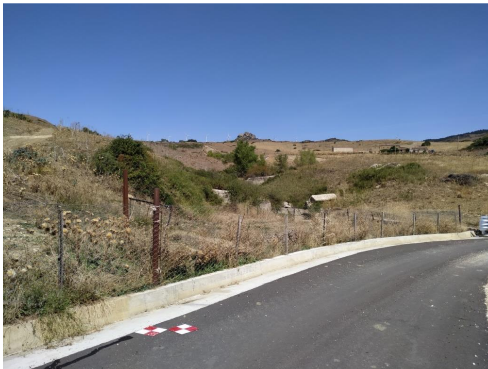
Figura 41- Foto panoramica A6
