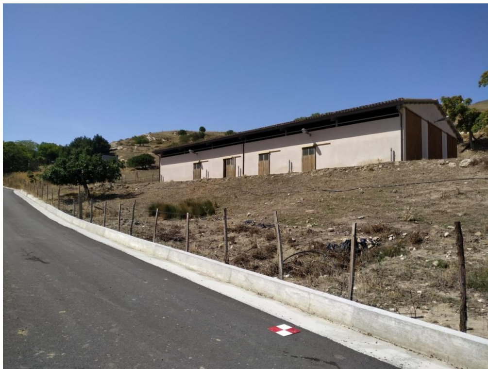
Figura 37- Foto panoramica A2
