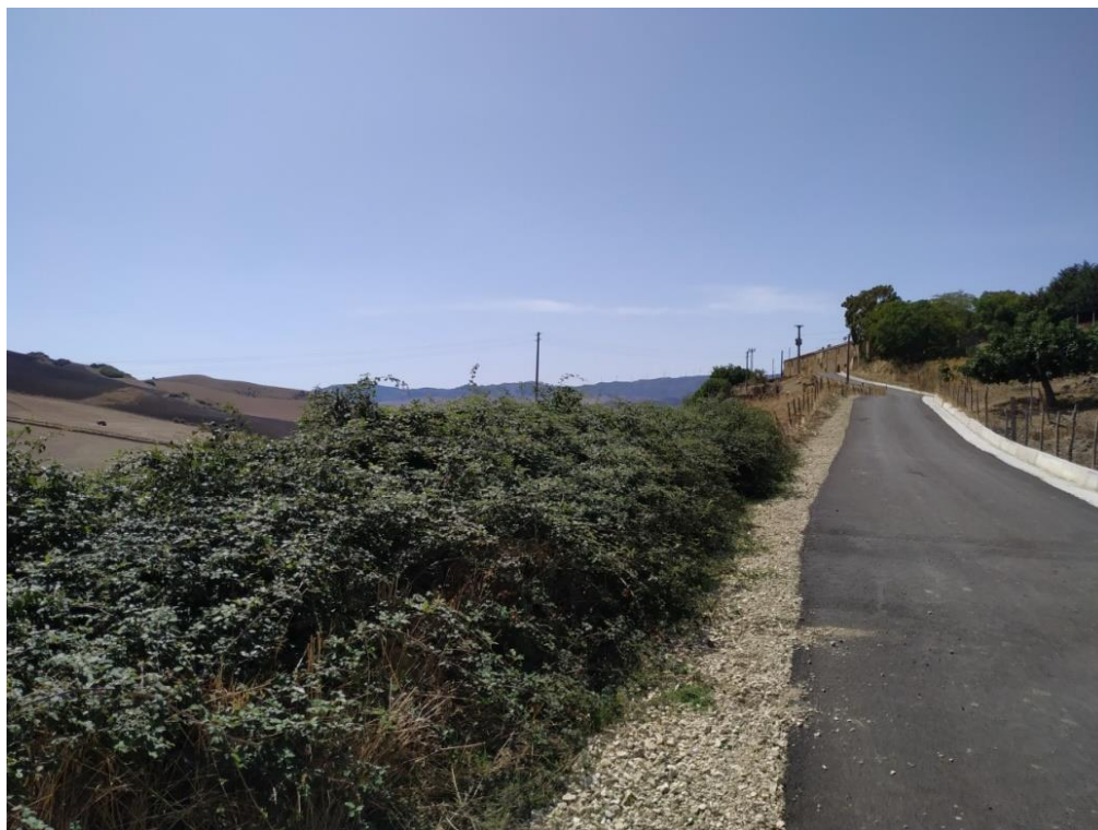
Figura 46- Foto panoramica A11
