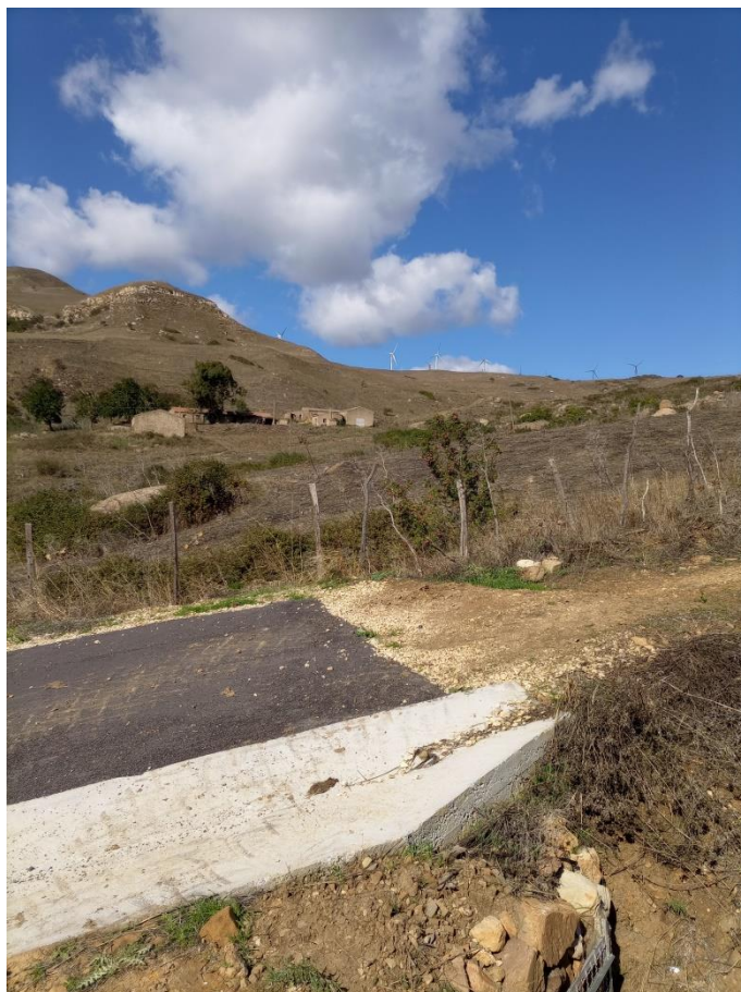
Figura 61- Foto panoramica C8
