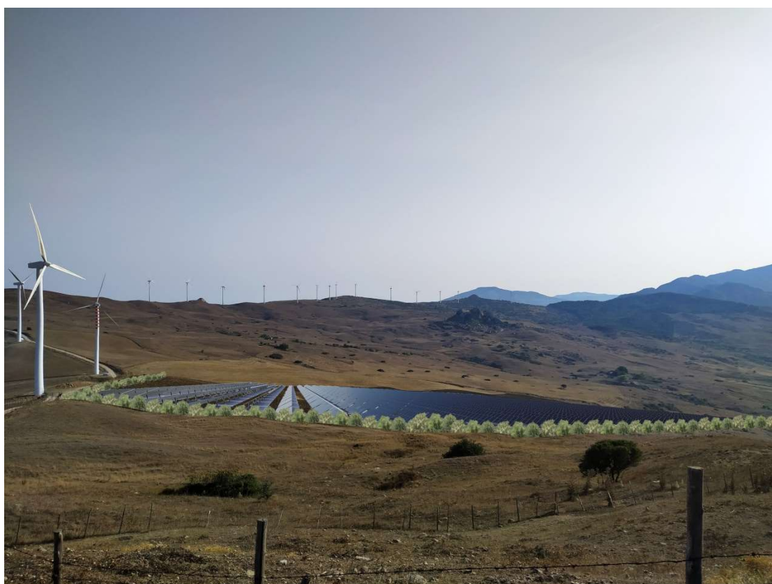
Figura 12 - Vista A post operam
