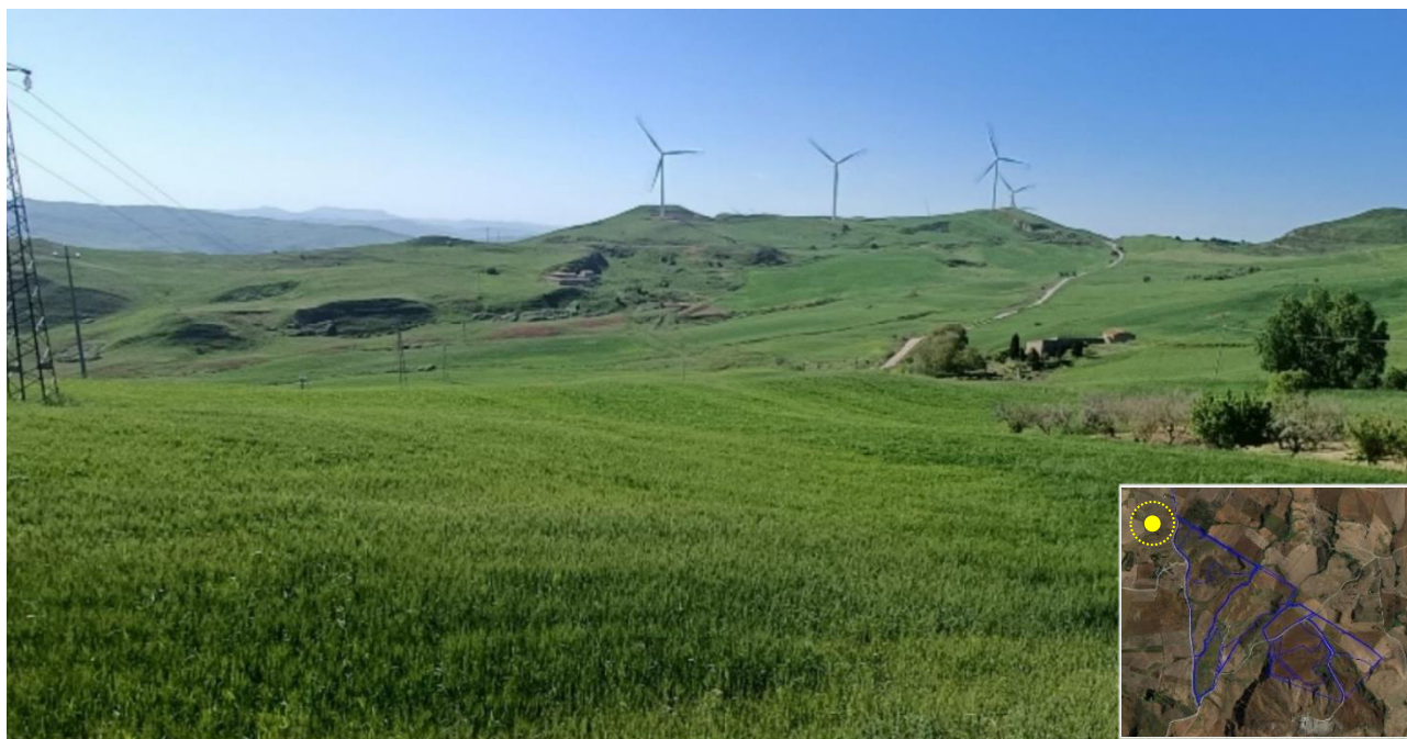
Figura 18. Ripresa panoramica dell'area di intervento vista da Nord-Ovest.
