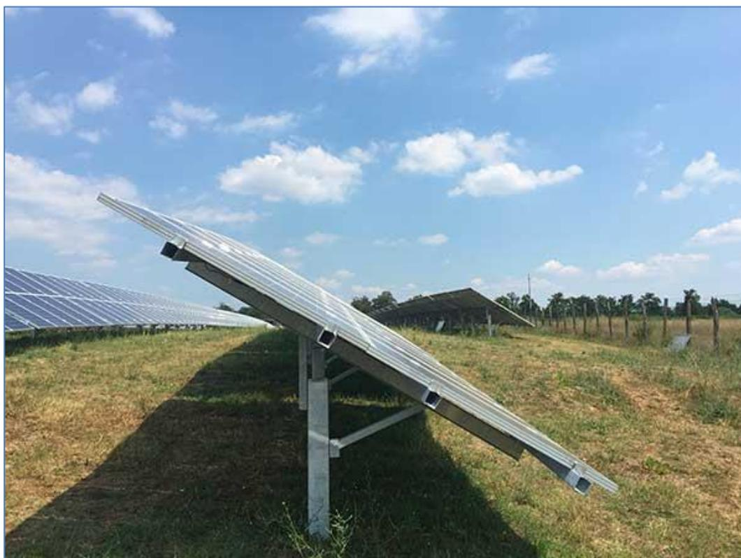
Figura 10. Esempio di struttura di supporto moduli fotovoltaici ad inclinazione/orientamento fissi
