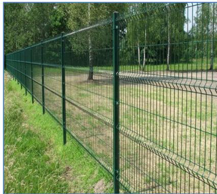
**Figura 5.** Esempio di recinzione perimetrale con pali ad infissione nel terreno senza utilizzo di plinti in cemento
