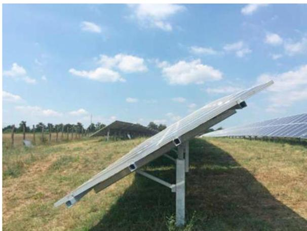
**Figura 40.** Esempio di moduli fotovoltaici installati su strutture fisse.
