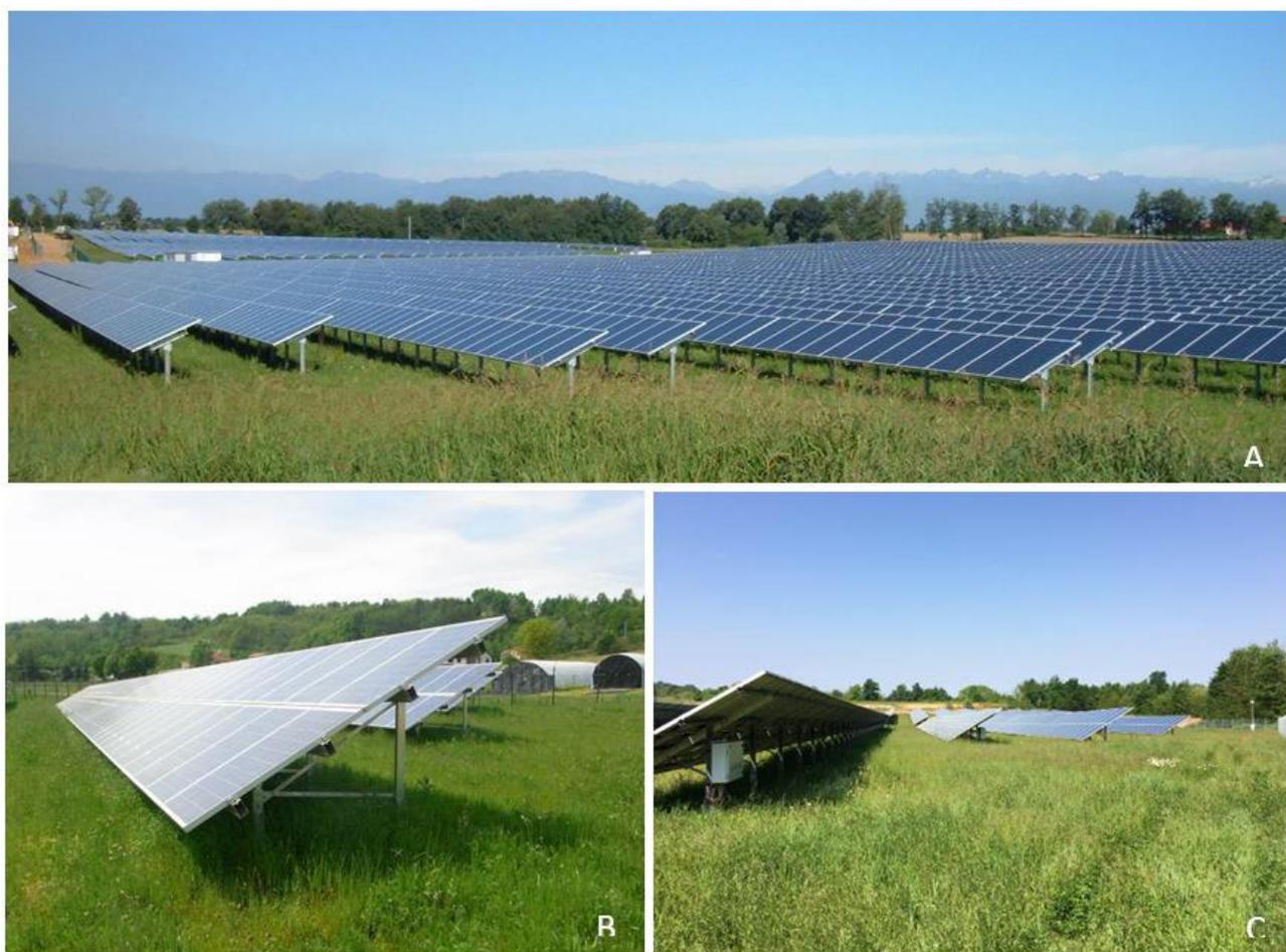
**Figura 68.** Immagini di grandi impianti fotovoltaici a terra (scattate dagli scriventi) riferite a progetti realizzati (anche con tecnologie differenti) che forniscono evidenza oggettiva dell'effetto non limitante dell'ombreggiamento generato per l'attività fotosintetica. A) Impianto FV "Ternavasso" – 7.5 MWp, Poirino (TO); B) Impianto FV "Cortiglione Green" – 0.8 MWp, Cortiglione (AT); C) Impianto FV "Sulpiano Cross" – 2.5 MWp, Montà (CN).
