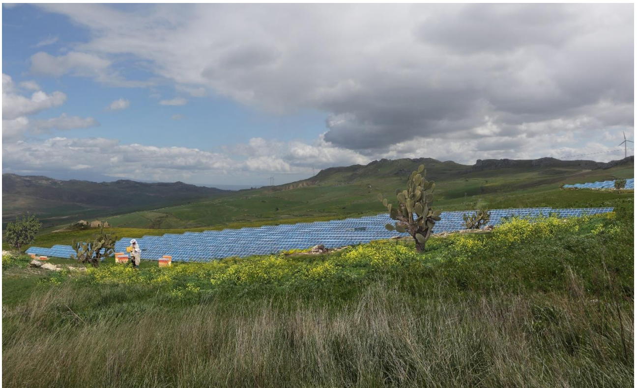
Figura 28: Foto inserimento impianto con particolare apicoltura e misure mitigazione
