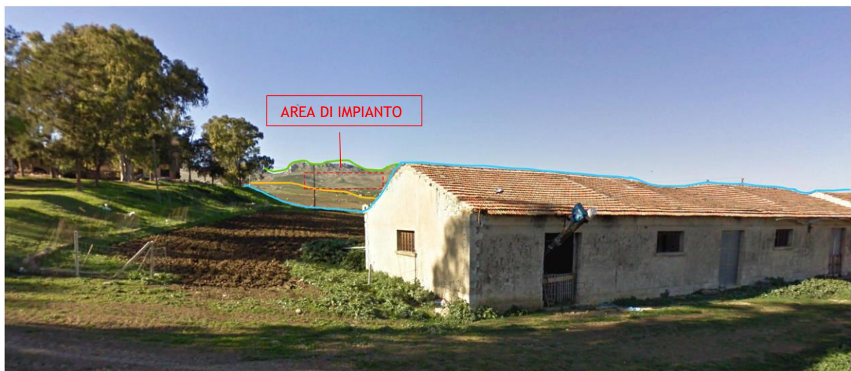
Figura 18: Borgo Pietrolupo - come visibile da Borgo Pietrolupo (in corrispondenza di SP 179) gli impianti esistenti non risultano visibili. L'unico impianto visibile è quello di Pietrolupo 02 che in ogni caso sarà in secondo piano rispetto ad altri elementi a caratteristici del paesaggio quali manufatti e vegetazione. Inoltre, la presenza delle misure di mitigazione garantiranno una schermatura naturale dell'impianto stesso tale da favorire il suo inserimento nel paesaggio.
