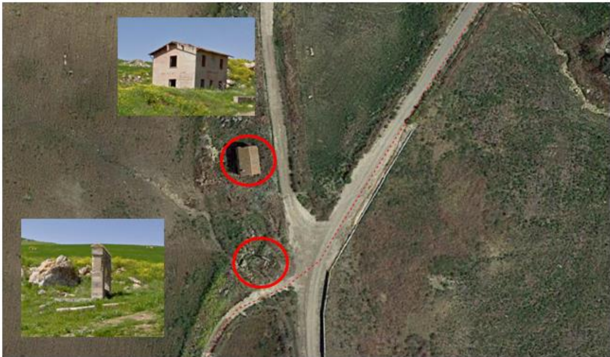
Figura 82: all'incrocio fra la SP 179 e la SP 182 sono collocati due beni censiti come beni isolati e in particolare 3. Abbeveratoio collocato a circa 10 metri dalla sezione di scavo del cavidotto; 4. Casa Cantoniera (Fig 16 Plla 246) collocata a circa 30 metri dalla sezione di scavo del cavidotto. Considerando una sezione di scavo di circa 0,6 m di larghezza ne deriva che il cavidotto non incide sul bene isolato.
