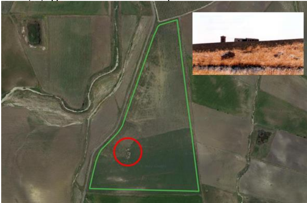
Figura 334: Casa in Contrada Mongialino. L'area perimetrata in verde verrà utilizzata per le opere di mitigazione/compensazione, pertanto, non verranno apportate modifiche o alterazioni al bene in questione. Nel caso in cui l'area sarà interessata ad interventi diversi, si prevederà una fascia di rispetto pari a circa 50 metri.
