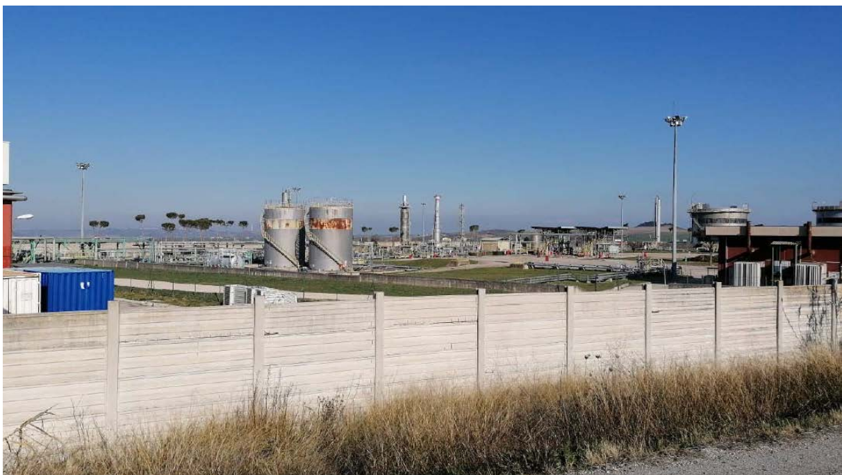
Figura 6-16 - centrale di Generazione Energia Elettrica
