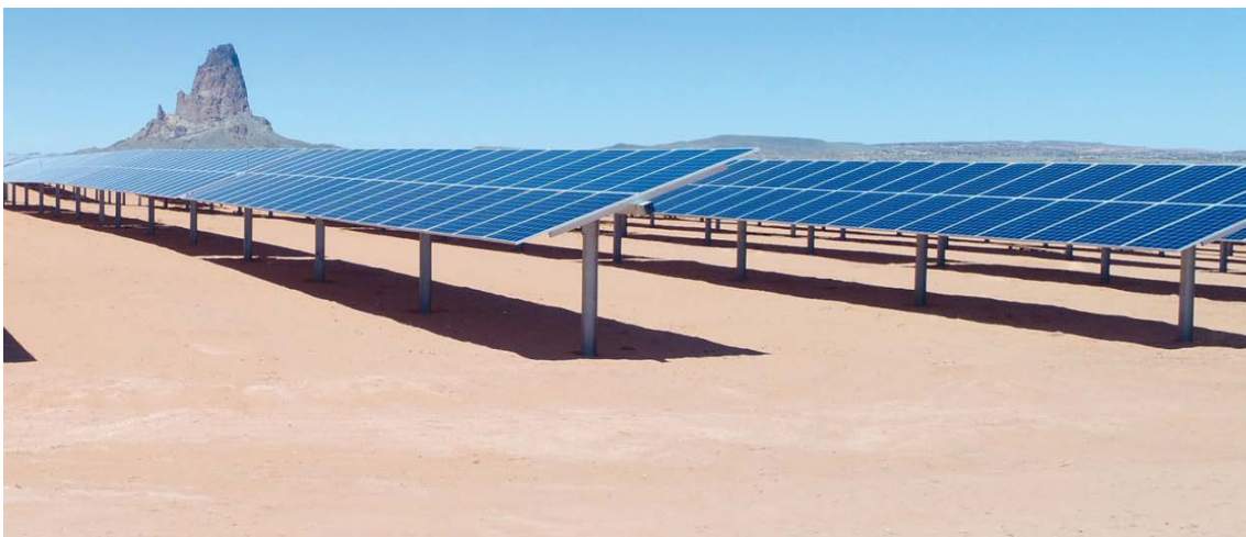
Figura 3-3 - Tipico tracker configurazione portrait (fonte: https://soltec.com/single-axis-solar-tracker/ )
