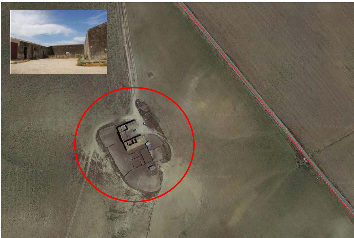
Figura 38: presso SP 182 si segnala la presenza di Masseria Giumenta (D1) in contrada Giumenta nel territorio comunale di Ramacca al Fg 81 Plla 125. Questa si colloca a circa 144 metri dalla sezione di scavo del cavidotto. Considerando una sezione di scavo di circa 0,6 m di larghezza ne deriva che il cavidotto non incide sul bene isolato.
