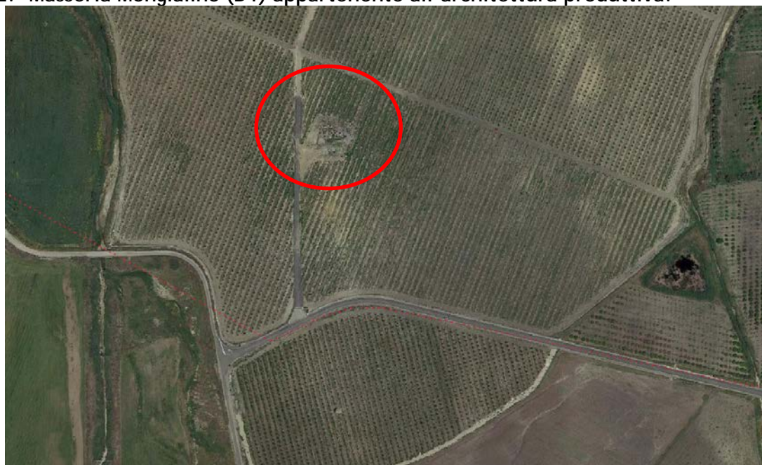
Figura 35: Masseria in Contrada Mongialino. Il bene è collocato lungo strada Provinciale 108 a circa 150 metri dal sedime stradale e pertanto l'opera non inciderà in alcun modo sul bene in questione.
