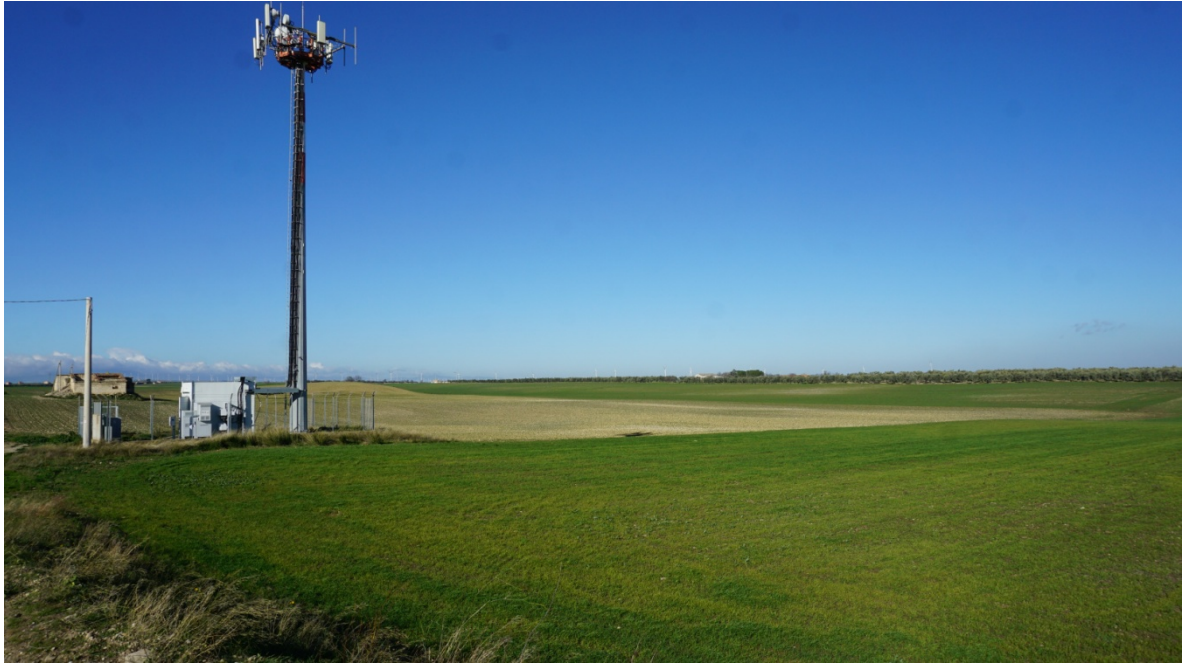
Viste 6 - del Campo 2 in direzione nord-oves ripresa da cavalcavia su SS. 655.
