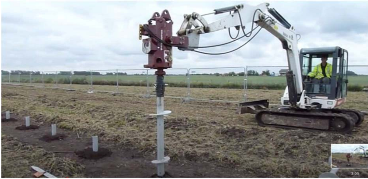
Figura 2-5 Macchina Operatrice per fissaggio supporti strutture
