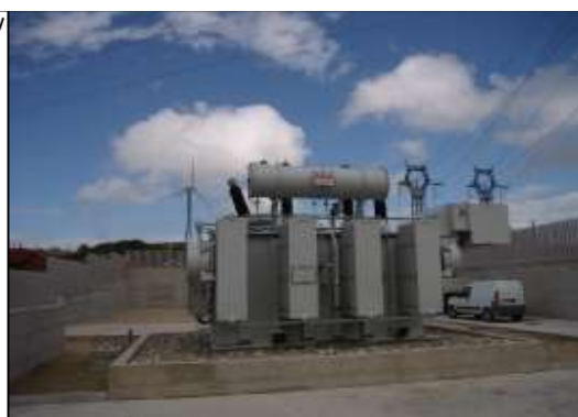
Figura 8-2 Trasformatore MT/AT
