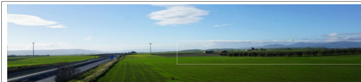
V8- Vista dal 2° cavalcavia su SS 655
