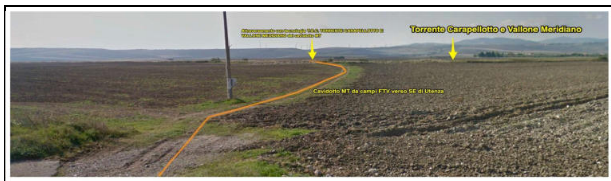
Figura 5-Punto 2 – Attraversamento cavidotto MT proveniente da Campi 1 e 2 con tecnologia T.O.C. DEL TORRENTE CARAPELLOTTO-VALLONE MERIDIANO
