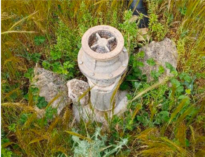
Figura 32. Punto di approvvigionamento delle acque identificato durante il sopralluogo.
