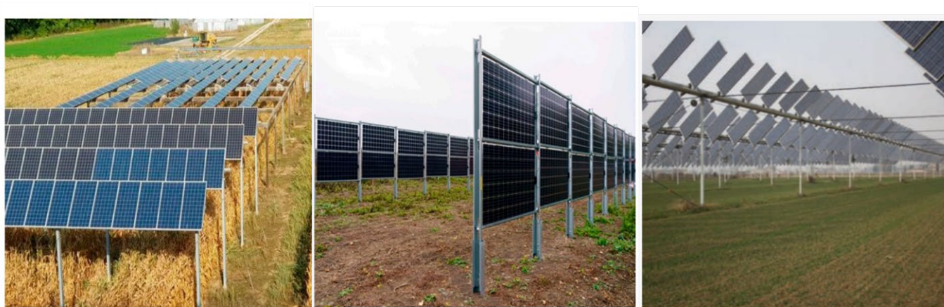
Figura 3. Esempi di differenti soluzioni agrivoltaiche: impianti fissi (Legambiente, 2020); moduli verticali; sistemi di inseguimento (Toledo e Scognamiglio, 2021); Sistema Agrovoltaico® ( https://remtec.energy/agrovoltaico ).
