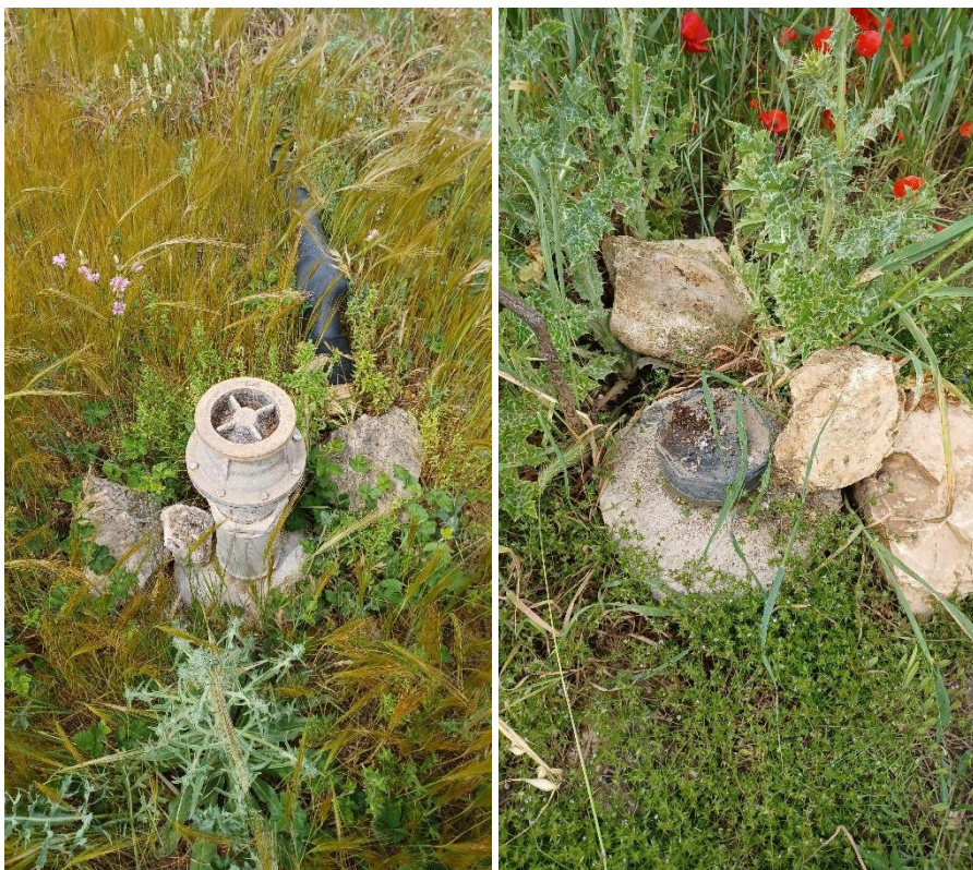
Figura 2.4: Manufatti Idraulici in Sito
