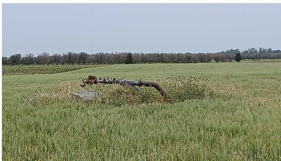
Figura 2.3: Manufatti Idraulici in Sito
