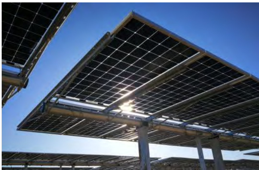
Figura 4.6: Esempio di struttura a tracker monoassiale
