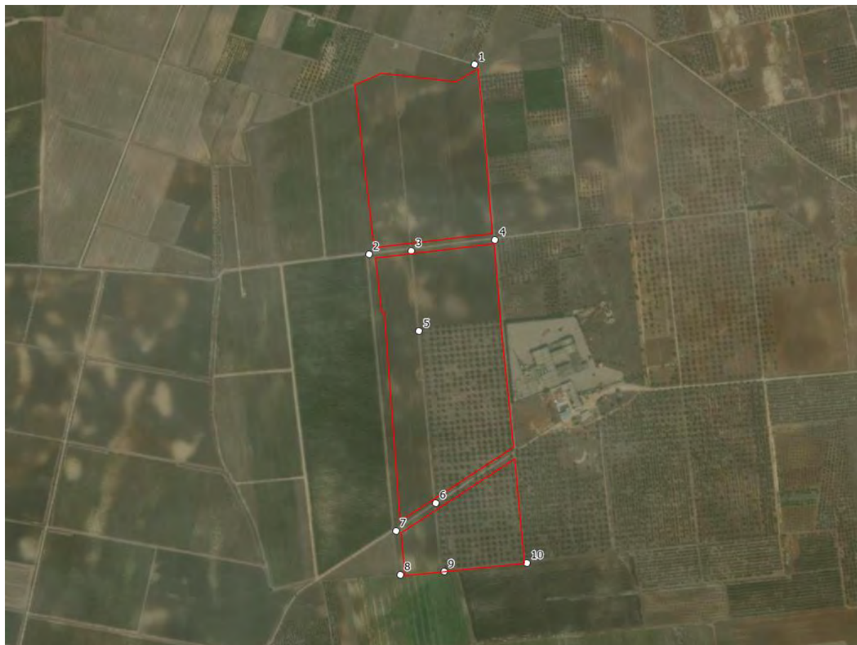
Figura 2.6: Punti di Presa Fotografica dell'Area Impianto
