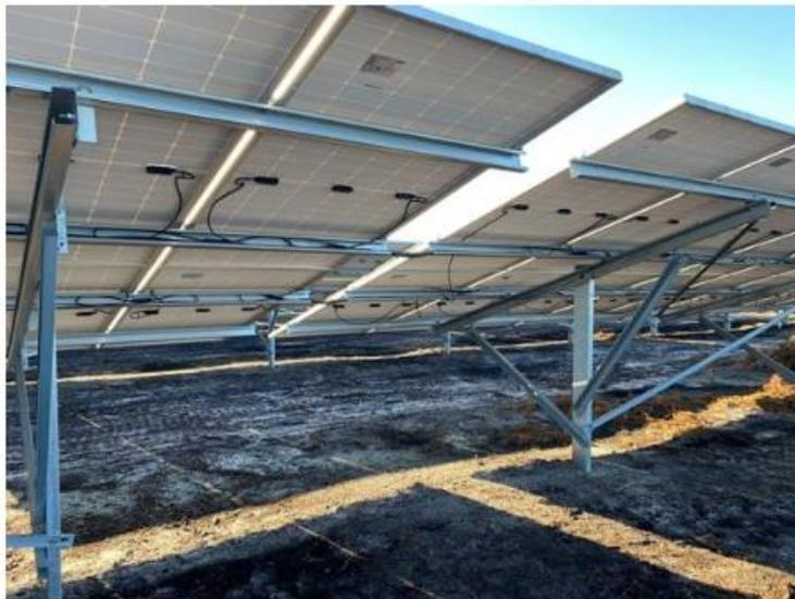
*Figura 7-rappresentazione della struttura di supporto - vista posteriore*
