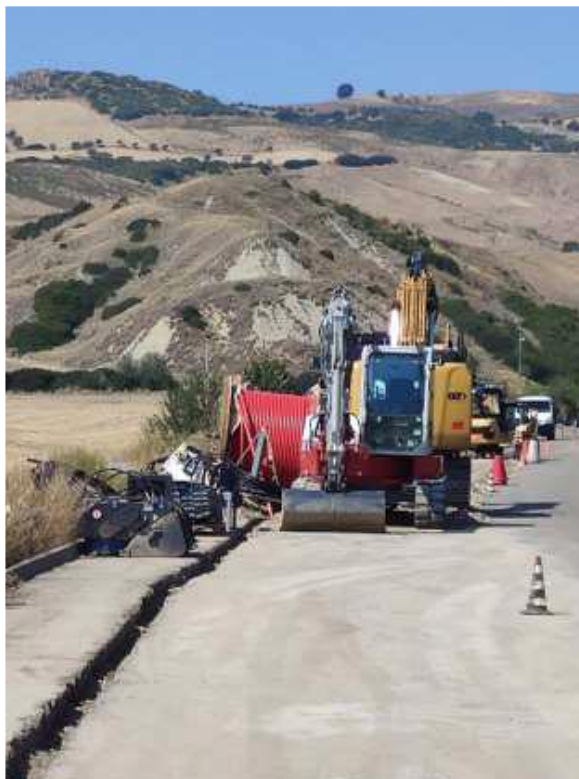
Figura 26 - Realizzazione scavo in mini trincea
