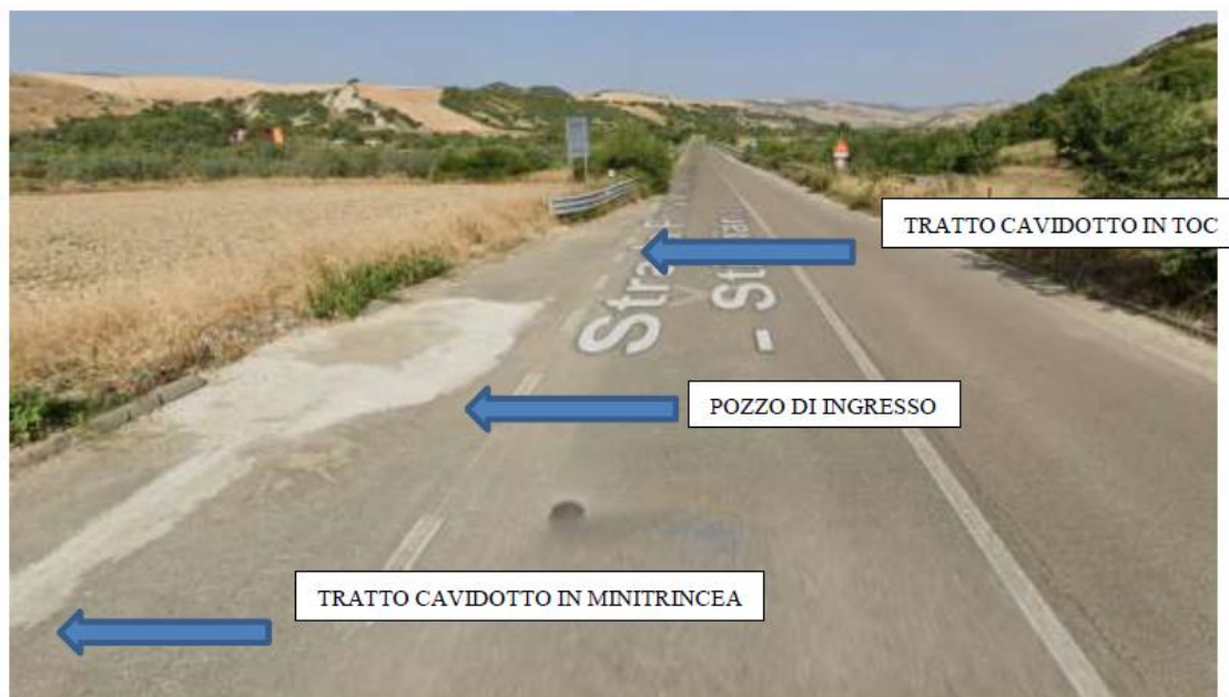
Figura 31 – Esempio di cavidotto in minitrincea, in toc e pozzetto di ingresso della TOC
