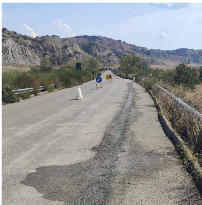
Figura 27 - Ripristino scavo in mini trincea
