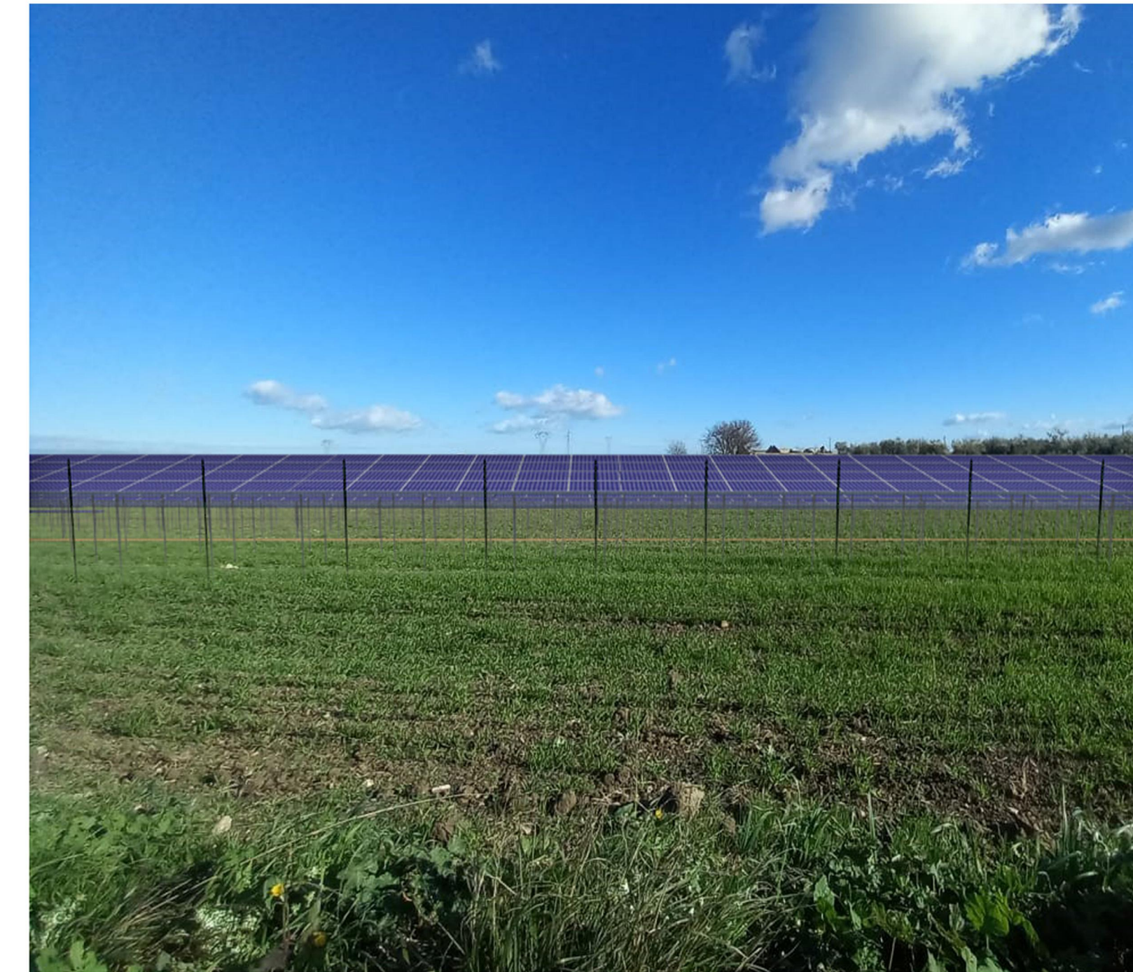
AREA IMPIANTO POST-OPERAM 2
