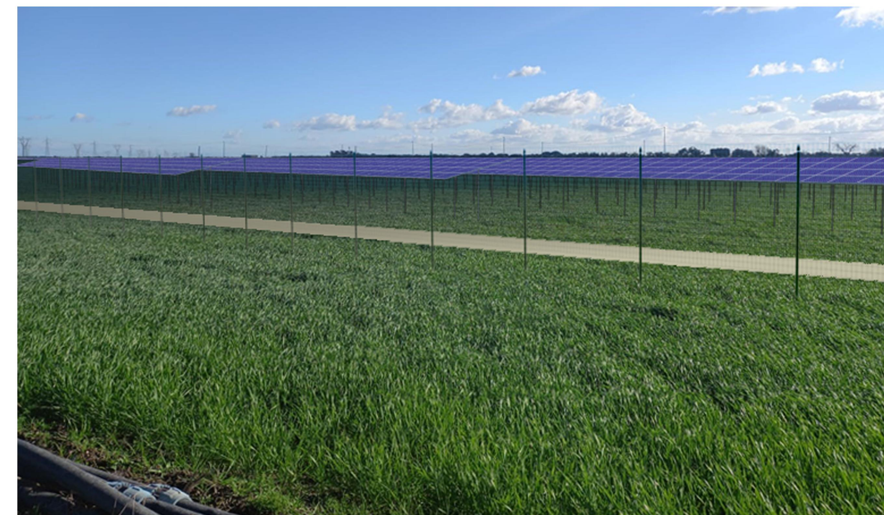
AREA IMPIANTO POST-OPERAM 5
