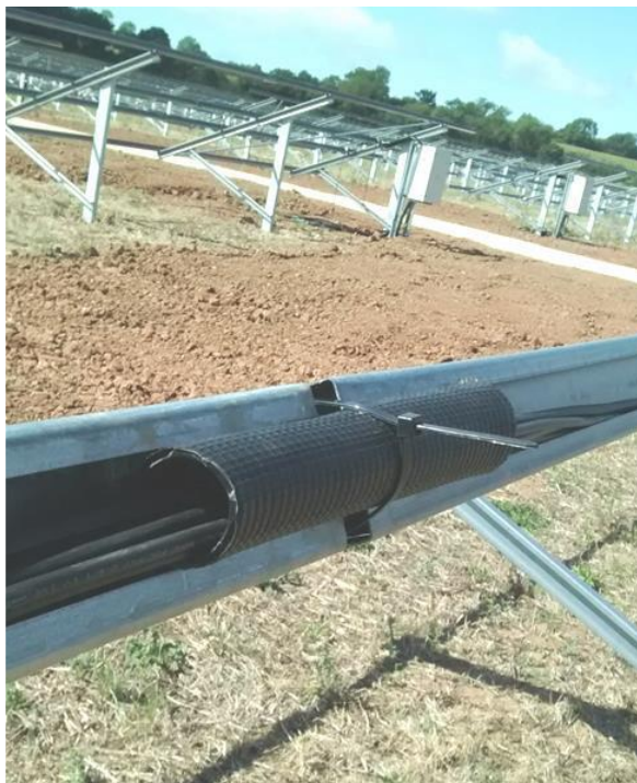
Figura 11 – Cablaggio stringhe
