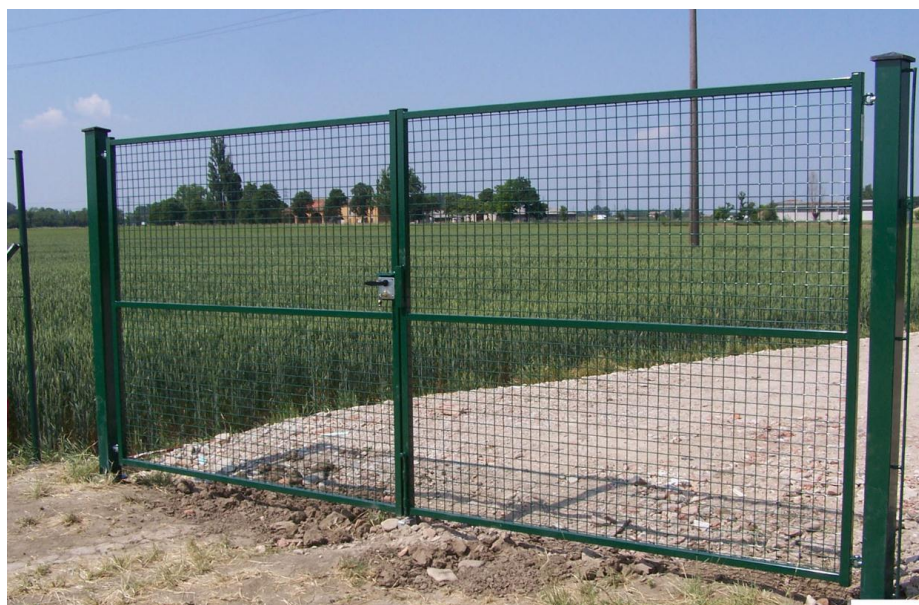
Figura 03- Esempio tipologico cancello della recinzione perimetrale
