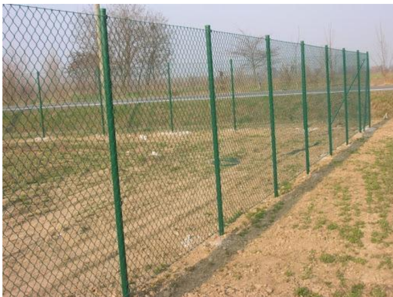
Figura 02- Esempio tipologico della recinzione perimetrale
