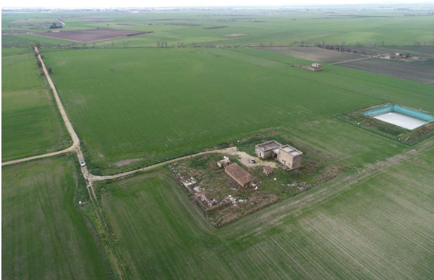
FOTO B- VISTA AEREA AREA LOTTO 2
