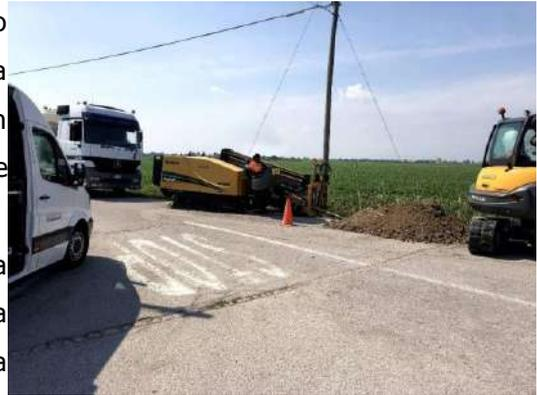
La prima vera e propria fase della perforazione è la realizzazione del "foro pilota", in cui il termine pilota sta ad indicare che la perforazione in questa fase è controllata ossia "pilotata". La "sonda radio" montata sulla punta di
