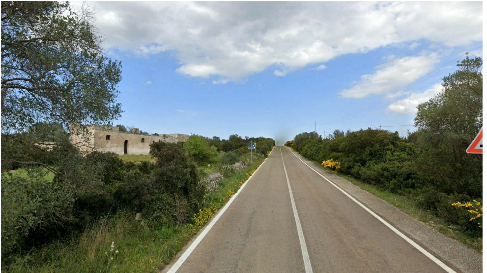
Punto di scatto n°4 SS 603 in corrispondenza della Masseria Cantagallo piccola .L'osservatore è posto in linea d'aria a circa 700 m dall'area d'intervento
