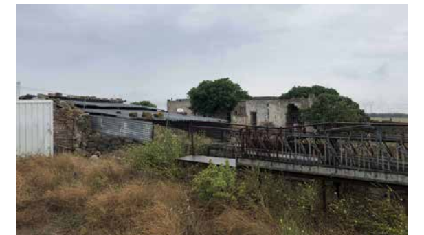
Foto masseria Roco Nuzzo, stato di fatto
