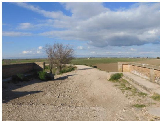
Figura 92 Ponte I Carapelle
