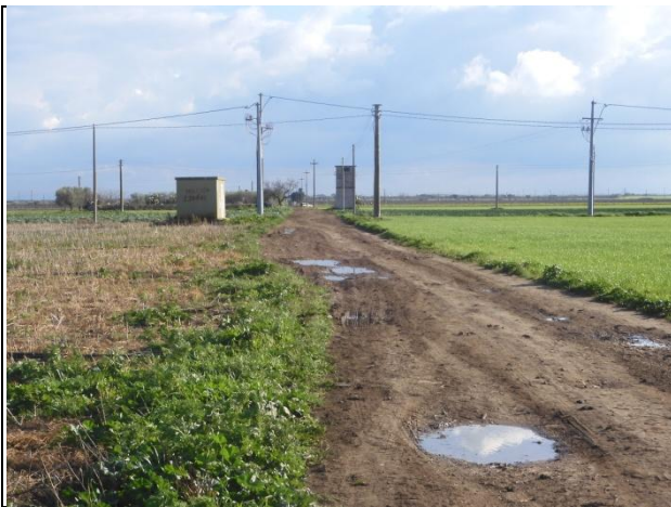
Figura 82 Prosecuzione percorso cavidotto su strada sterrata
