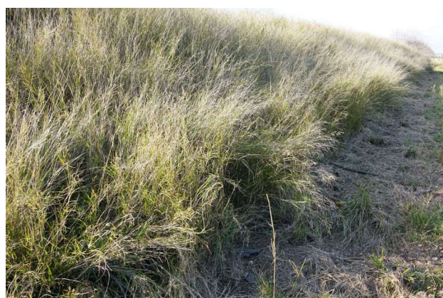
Foto 16. Terrapieno di contenimento di una vasca a fini irrigui.
