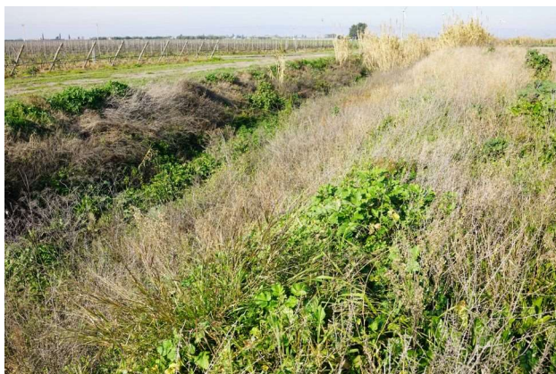
Foto 13. Interno di un canale per il deflusso delle acque superficiali, probabilmente risalente agli anni Trenta.
