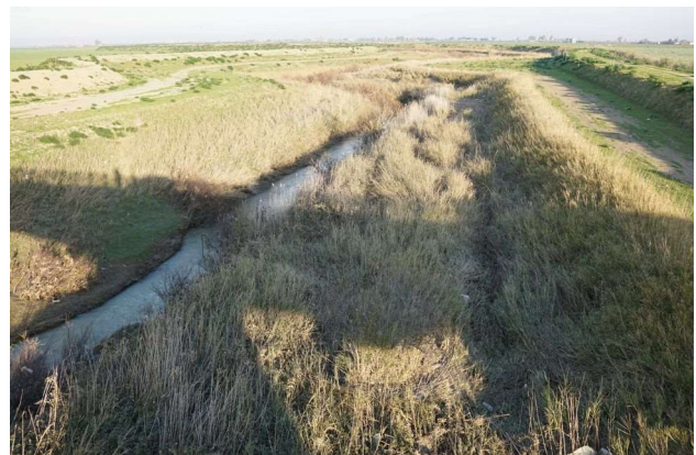
Foto 10. Veduta del torrente Carapelle dal Ponte Bonassisi.
