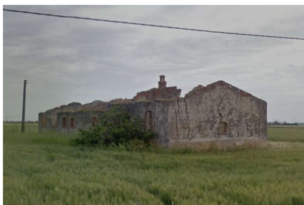
Foto 28. Edificio complesso, si potrebbe dire masserizio, di un podere risalente alle opere della Bonifica Integrale degli anni Trenta. Retro.
