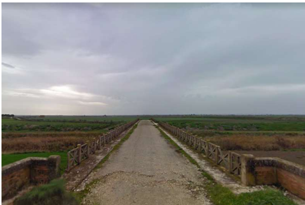
Foto 11. Veduta del Ponte Bonassisi.
