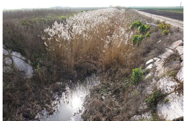
Foto 12. Interno di un canale per il deflusso delle acque superficiali, probabilmente risalente agli anni Trenta.
