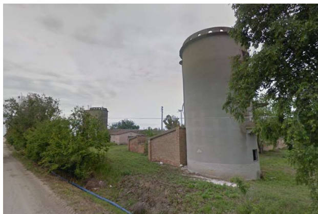
Foto 24. Azienda Agricola Macchia Rotonda (secondo la dicitura della cartografia di base IGM) o Masseria Rotonda (secondo la dicitura della CTR). Particolare dei silos.
