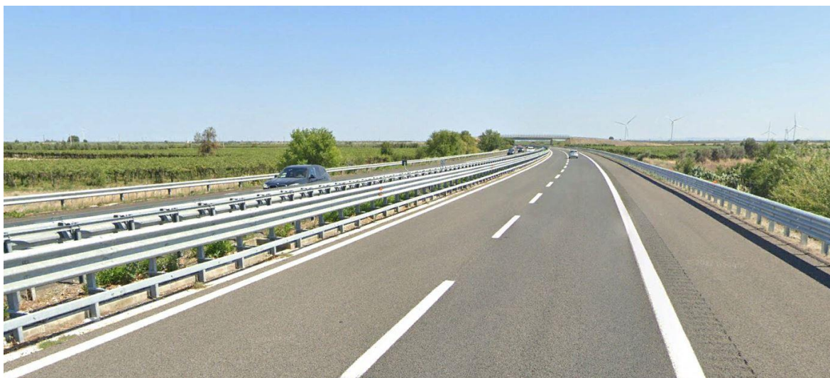
Figura 2-52: Panoramica dal Punto 08- post operam
