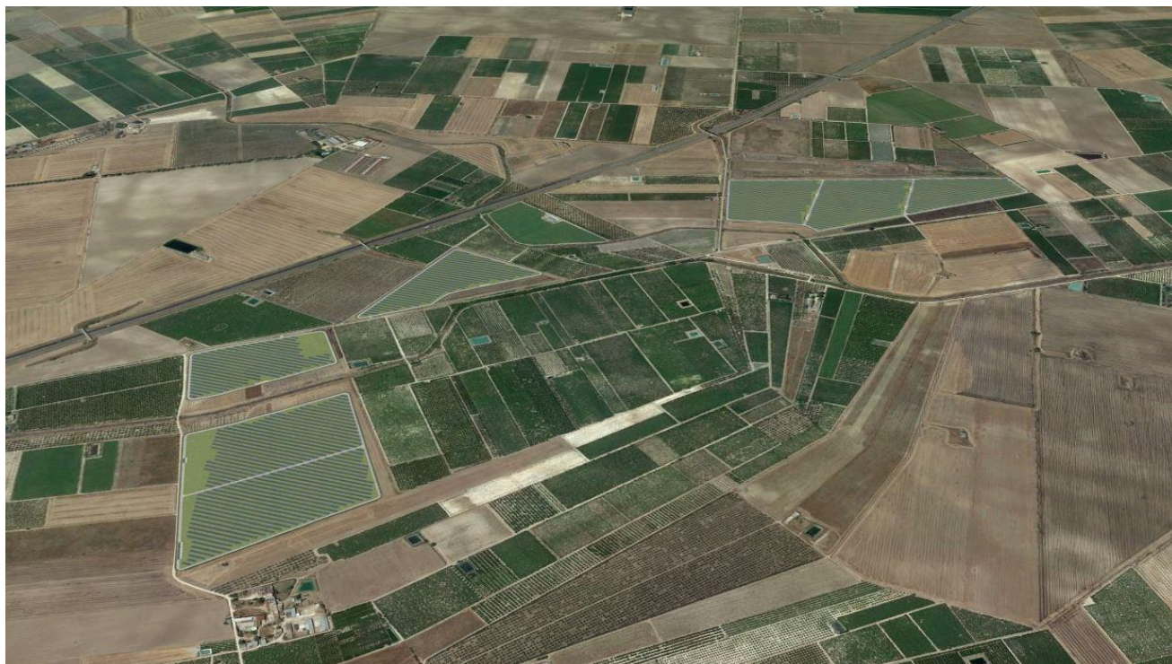
Figura 2-60: Vista aerea dell'impianto da Est
