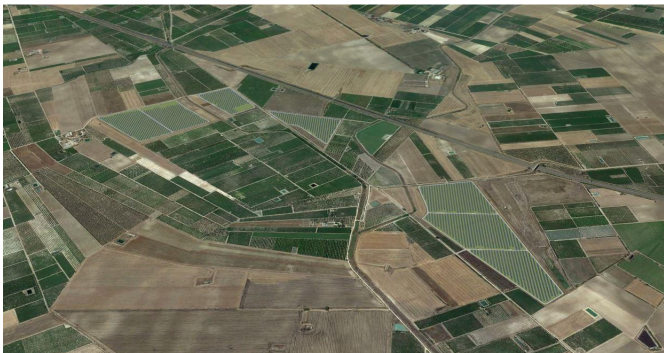
Figura 2-62: Vista aerea dell'impianto da Nord
