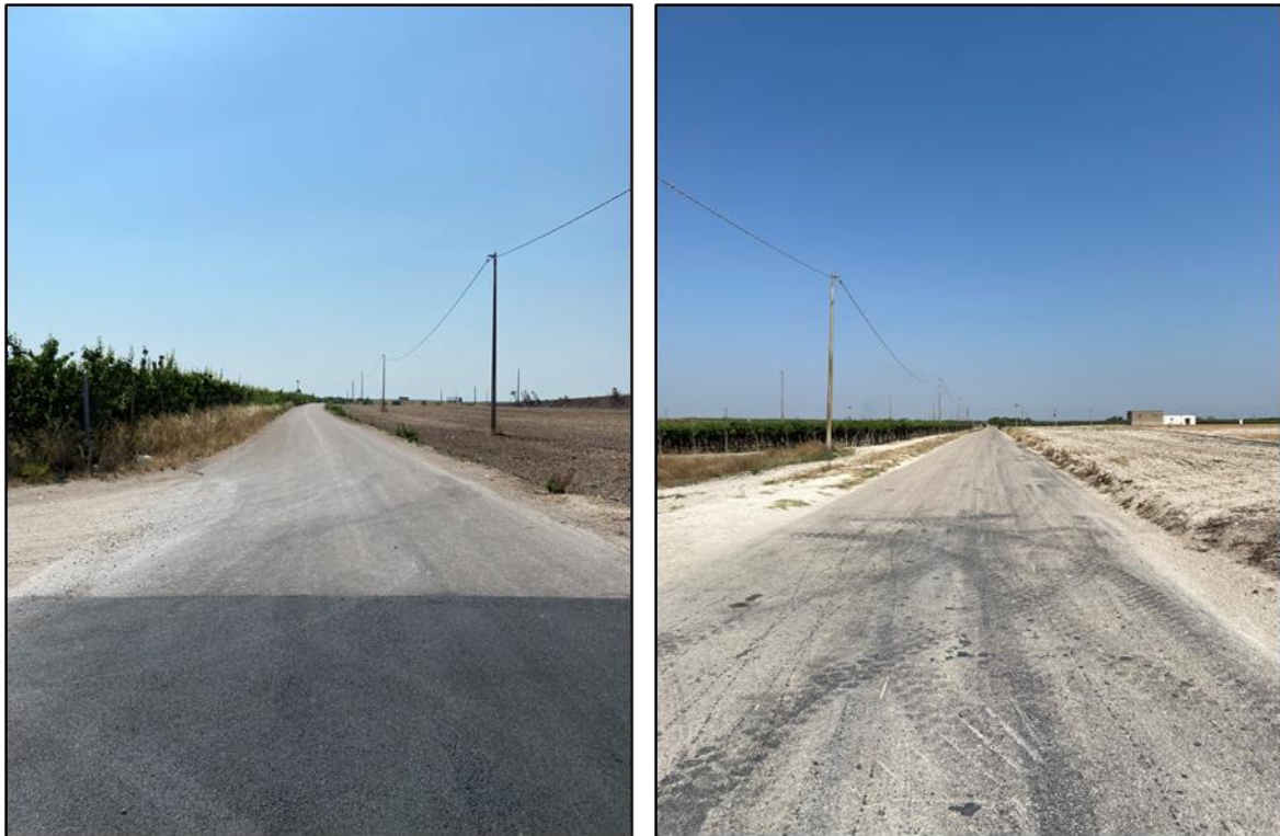
Foto 15 – 16: Viabilità stradale (Strada Provinciale 72)
