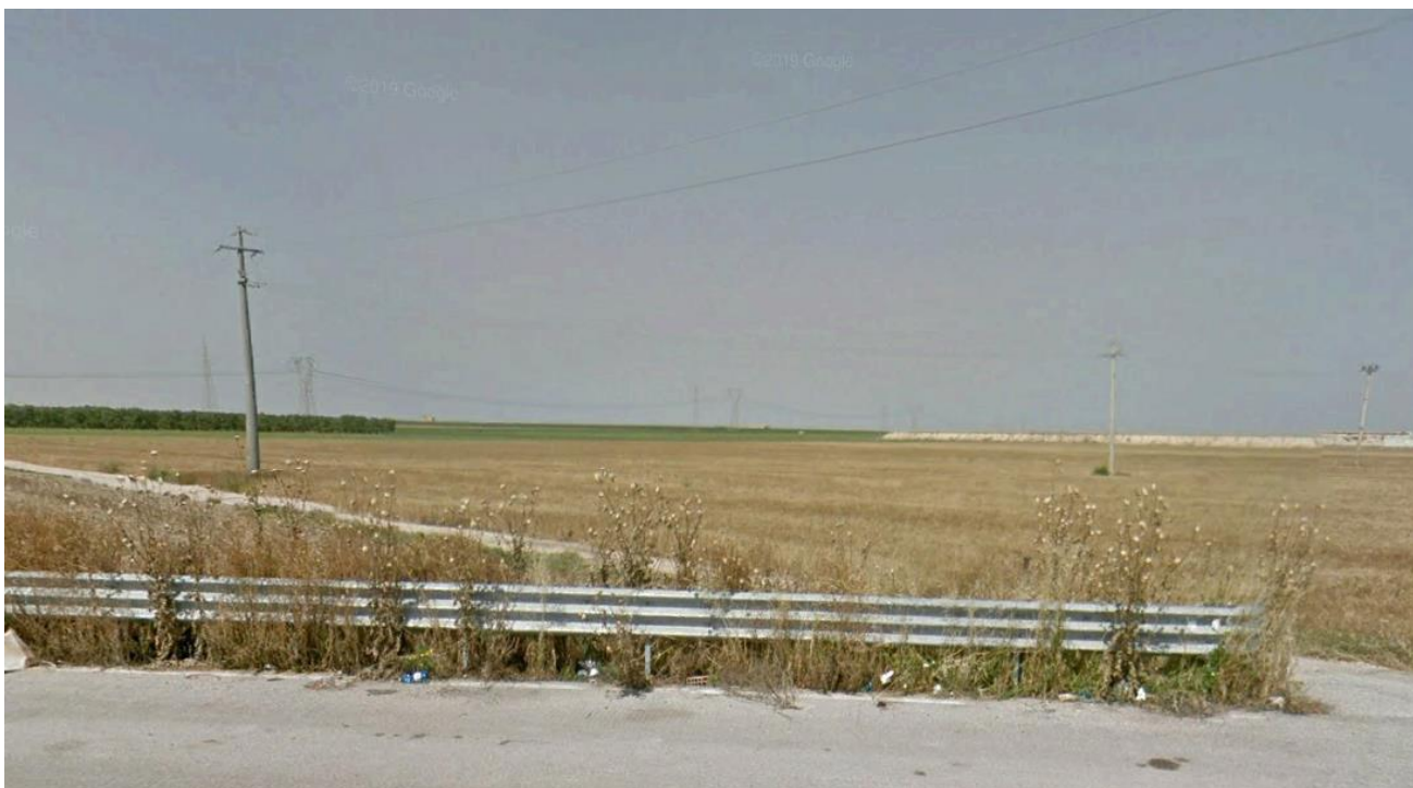
Figura 3-18: Area di installazione della Stazione elettrica utente e della Stazione elettrica TERNA
