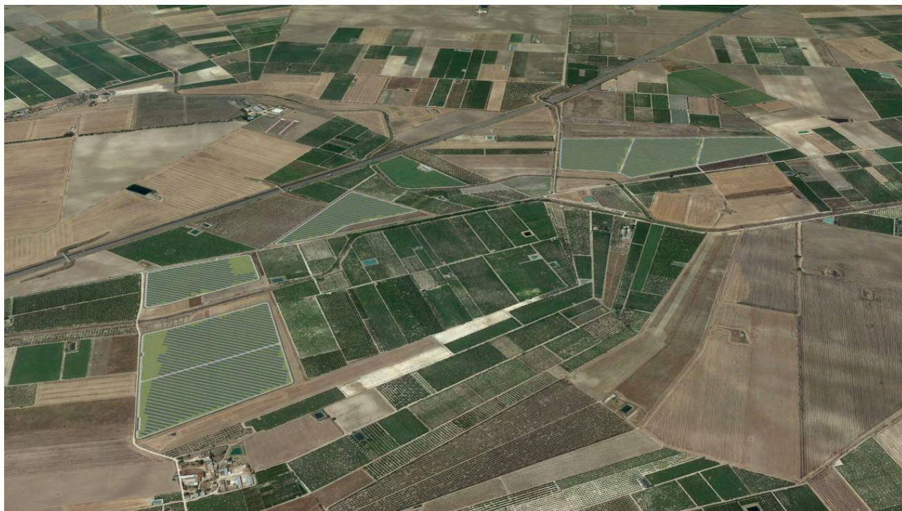
Figura 15-42: Vista aerea dell'impianto da Est
