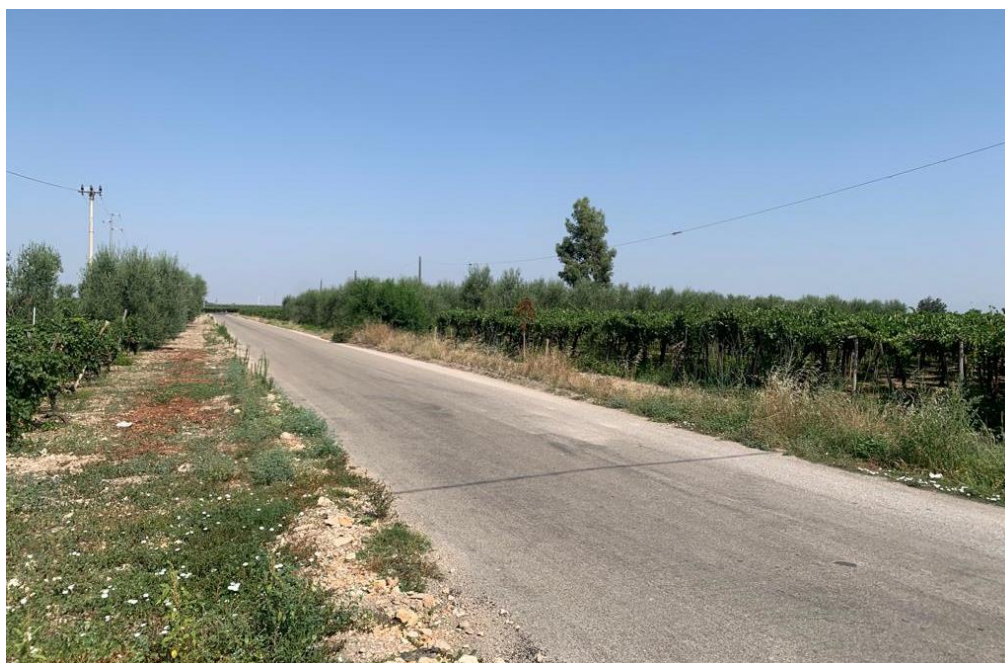
Figura 15-19: Panoramica dal Punto 01- ante operam
