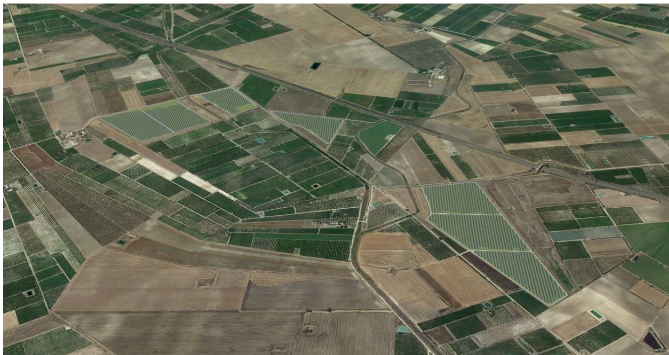
Figura 15-44: Vista aerea dell'impianto da Nord
