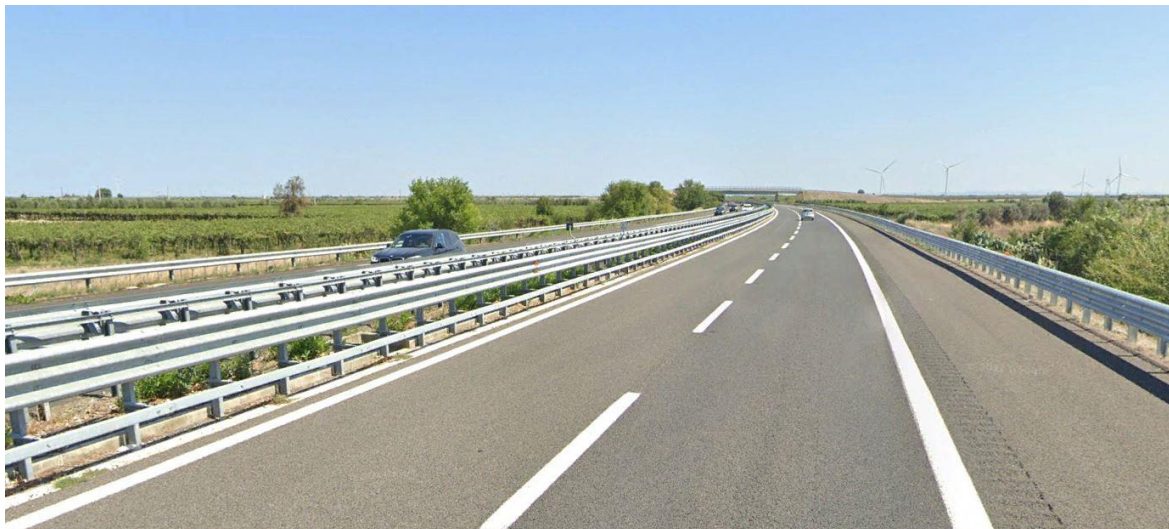
Figura 15-33: Panoramica dal Punto 08- ante operam
