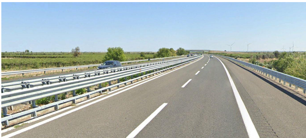
Figura 15-34: Panoramica dal Punto 08- post operam
