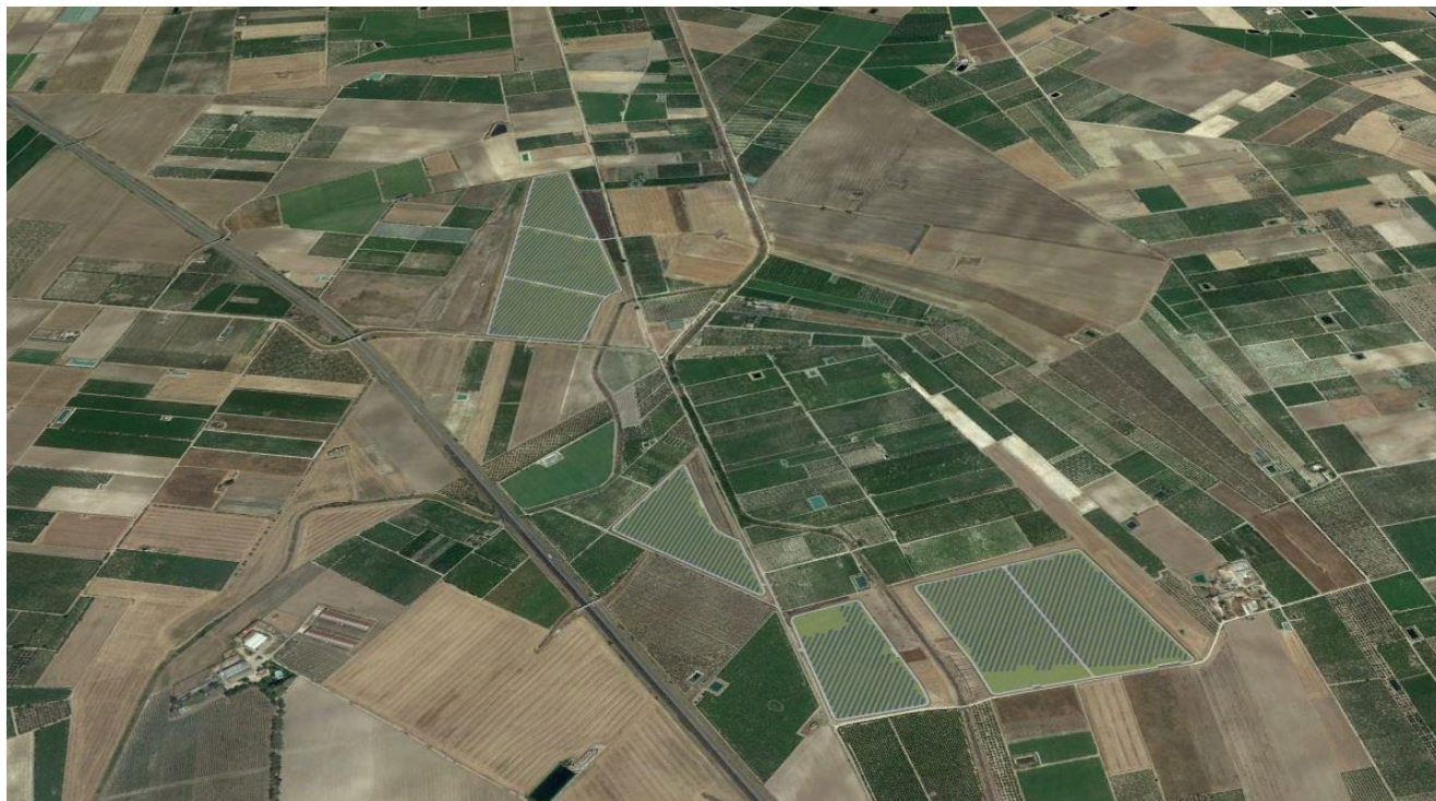
Figura 15-41: Vista aerea dell'impianto da Sud
