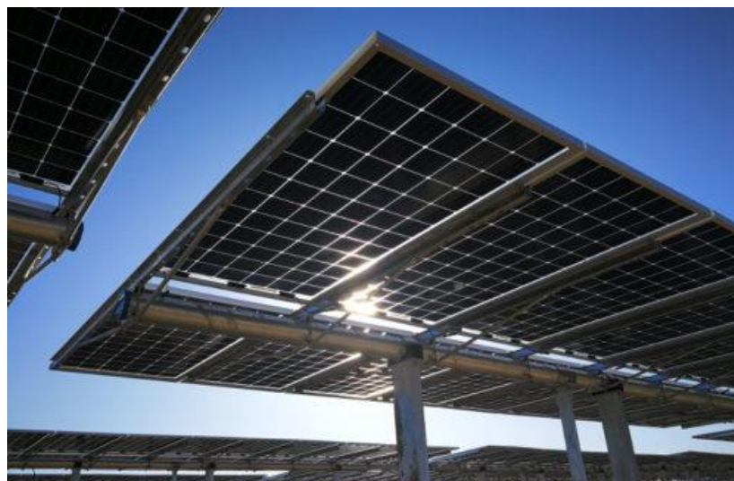
Figura 3.3 Esempio di struttura a tracker monoassiale.
